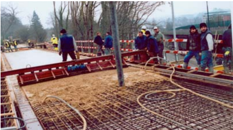
Mise en œuvre du béton.
