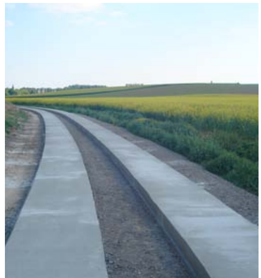
Mise en œuvre d'une voirie bi-bandes.
