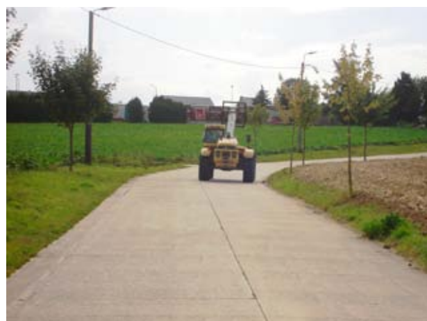
Vu sa durabilité et les frais d'entretien pratiquement nuls, il n'est pas étonnant qu'on ait choisi le béton pour la construction des routes rurales et de remembrement et ce depuis les années '50. En Belgique, le pourcentage de routes rurales en béton se situe entre 50 et 60 %.
