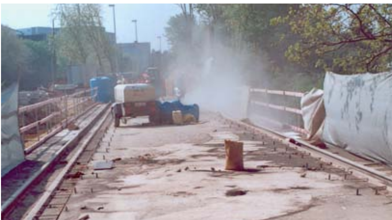
Sablage du béton durci et aspect du béton.
