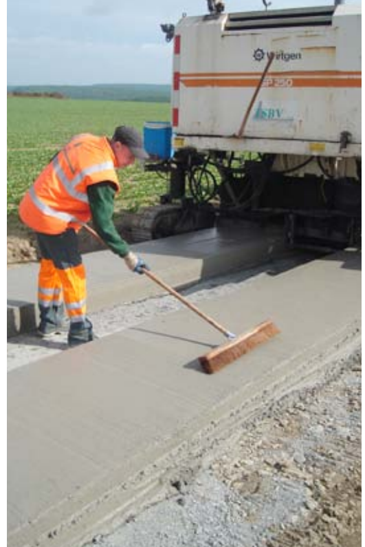
Mise en œuvre d'une voirie bi-bandes.
