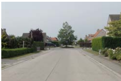
Revêtement de route dans le quartier 'De Biesten', réalisé in 1990.
