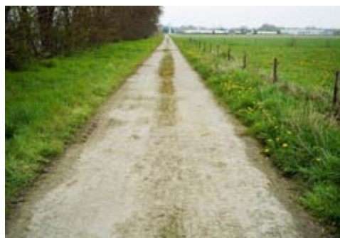
Chemin en béton sec compacté à Diepenbeek. Mise en œuvre en 1998 et état actuel de la route en 2011.
