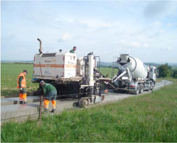
Mise en œuvre d'une voirie bi-bandes.
