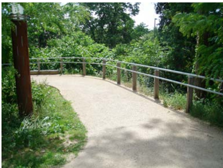
Accès en forte pente au tronçon de la Promenade Verte empruntant l'ancienne ligne ferroviaire L160 Bruxelles-Tervueren à Auderghem, à Woluwe-Saint-Pierre et à Woluwe-Saint-Lambert.
