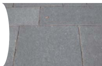
■ Blocs de pierre en granit
