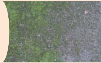
■ Colonisation des enrobés par les mousses
