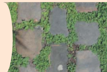
■ Végétation encouragée entre pavés jointoyés au sable
