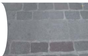
■ Pavés en granit avec joints ciment
