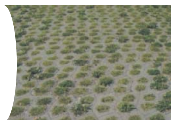
■ Dalles alvéolaires intégrant une surface engazonnée
