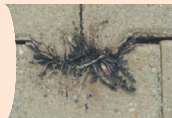
■ Désherbage thermique entre pavés autobloquants
