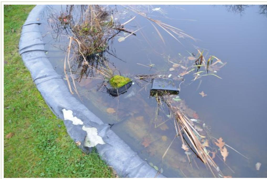
Dégâts suite à une mauvaise intégration de la bâche dans le sol. Une large bande de bâche est aussi visible et peu esthétique. (ECOWAL©)
